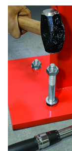
Fixation de structure métallique
